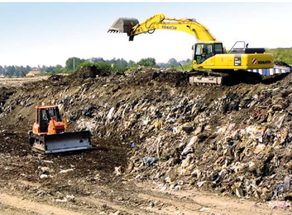
Figura 6 - Escavazione dei rifiuti nel corso delle operazioni di landfill mining presso la discarica di Modena
